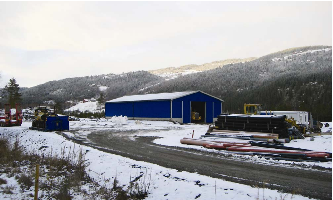
Ei ny verksemd ved vegen. Dette er ein aktivitet som ikkje treng vere godt synleg. Hallen burde hatt nøytral farge og vore lagt slik at han skjerma for innsyn til lager og oppbevaringsplass frå vegen. I tillegg burde noko av vegetasjonen stått att langs vegen. Foto: Jan Arne Sebuødegård.
