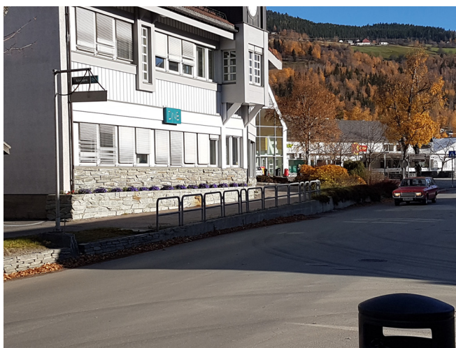
Området rundt DnB-bygget ligger høyere enn Jernbanevegen, og skaper en uheldig barriere mellom fortau og vei. Foto: Kristi Westerbø
