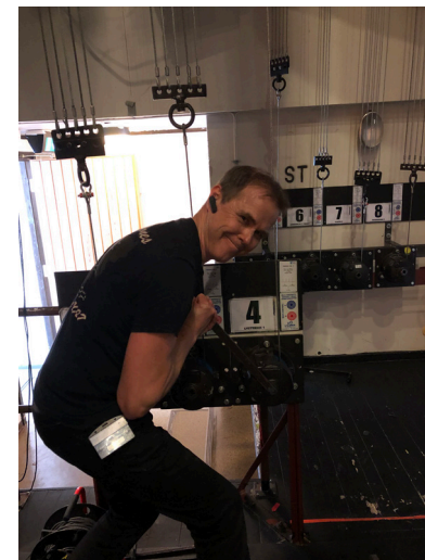
Trosser til oppheng i salen sveives manuelt med last på opptil 150 kg. Foto: Renate Øverseth
