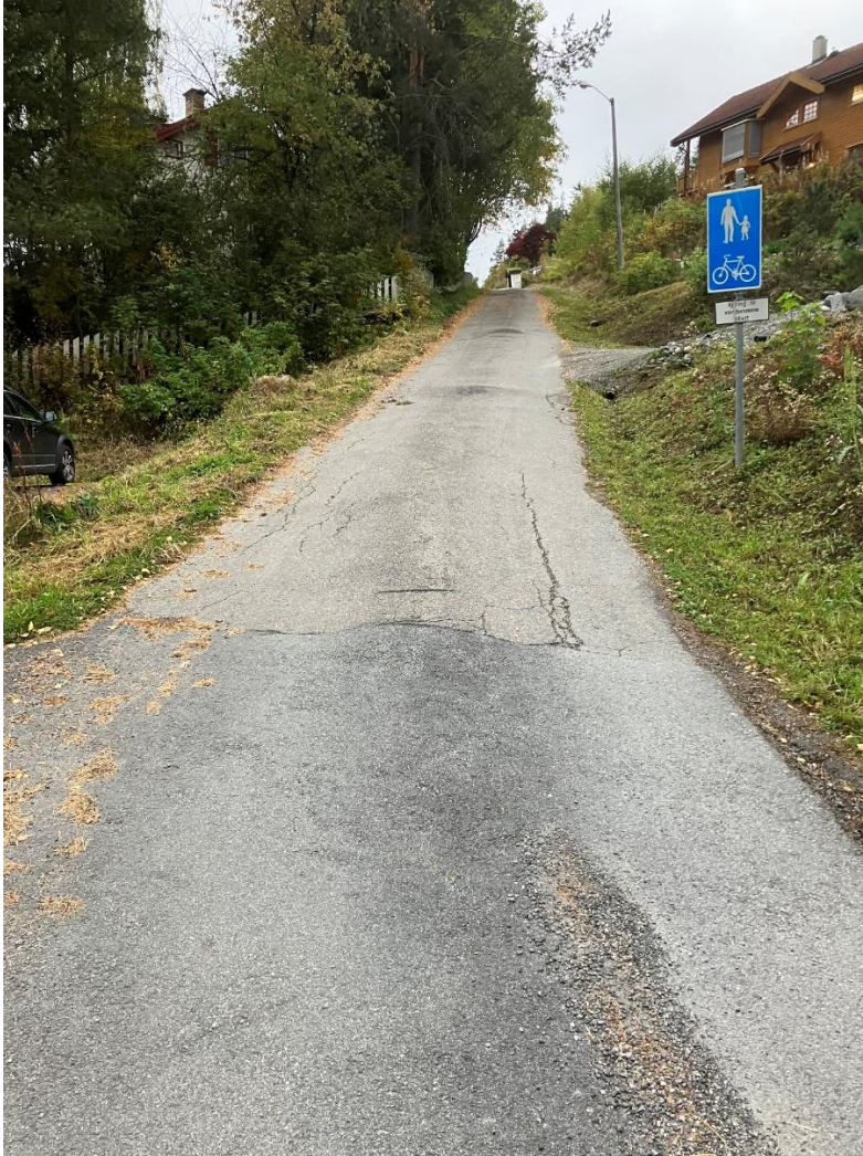
Gangveg fra Krokabakkatn til Nilsebrøtin
