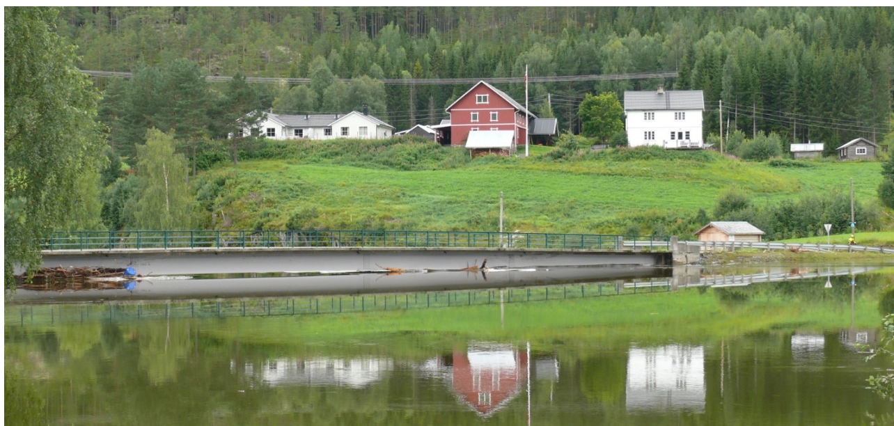
Figur 12 Sundvoll bru 11.8.2023. Foto: Jon Olav Stranden.
